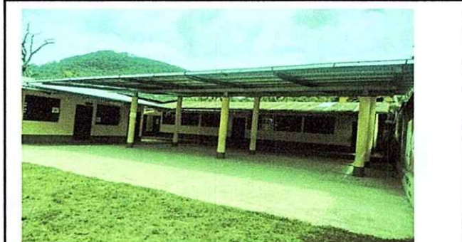
Foto 4: Pintura: aplicación de pintura del edificio de la EORM Aldea Chicoyoj Sector I, dentro fuera del aula y muro perimetral de la escuela.
