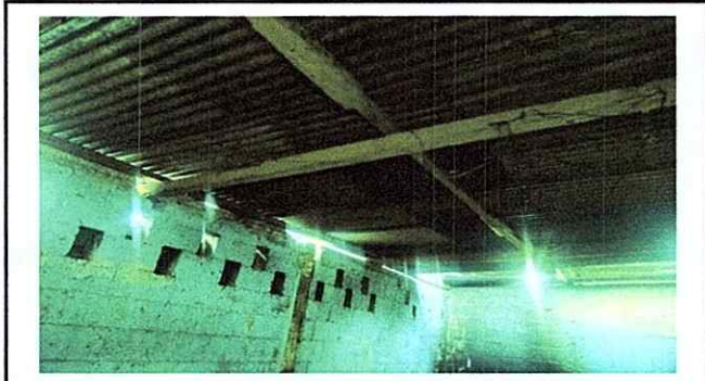
FOTO 1: Reparación de cocina: cambio de infraestructura, laminas, cernido, cemento para paredes, canalización de concreto para desfogue de agua de lluvia e instalación de cableado eléctrica, focos y accesorios.
